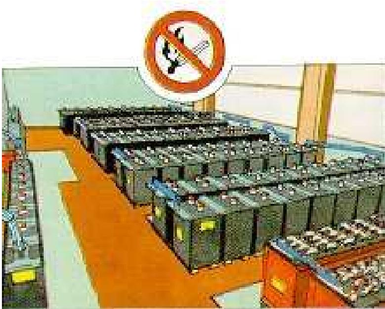
Nei locali ove sono installate batterie di accumulatori, è vietato fumare e usare fiamme libere, in quanto possono essere presenti miscele gassose esplosive. Per l'esecuzione dei lavori adottare le cautele del caso (aerazione adeguata, sospensione della carica, ecc.).
